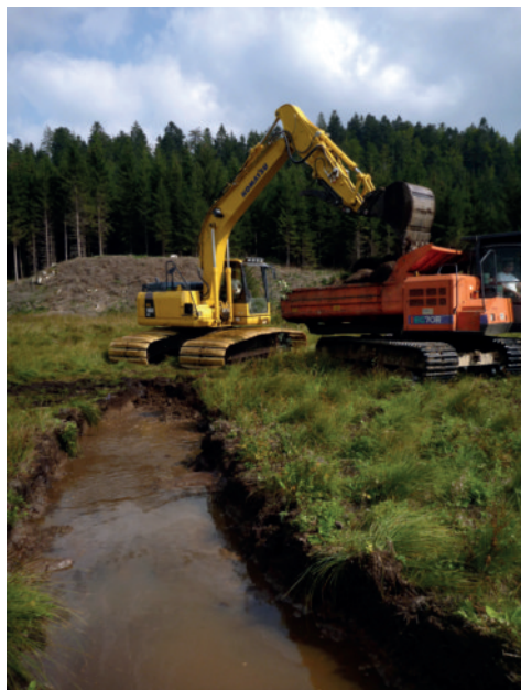
↑ Neutralisation de drains à Bas-marais de Mont de Voyon aux Granges-Narboz (25) Source : Life Tourbières Jura
