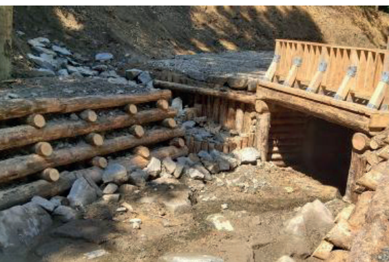
↑ Petite rétention et lutte contre l'érosion hydrique en zone de montagne Source : Centre de coordination des projets environnementaux, Pologne
