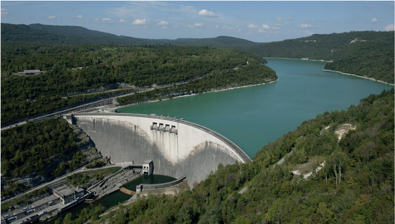
↑ Le barrage de Vouglans au pied du Massif du Jura, troisième plus grand réservoir hydroélectrique de France Source : EDF
