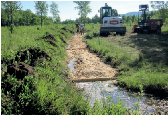
↑ Neutralisation de drains à Bas-marais de Mont de Voyon aux Granges-Narboz (25) Source : Life Tourbières Jura
